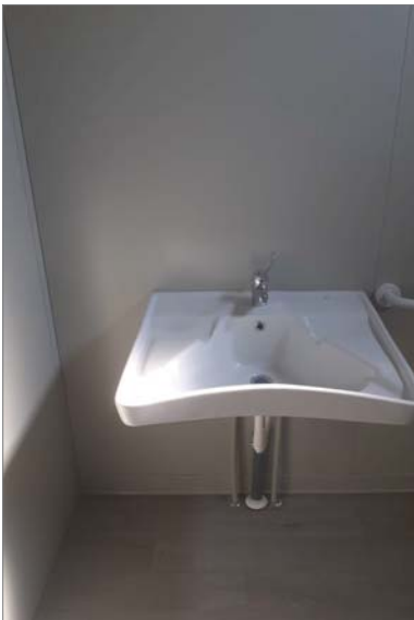
Foto punto di visuale 2 (fabbricato A)
