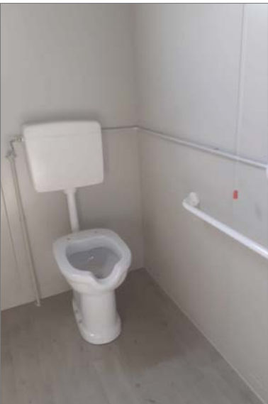
Foto punto di visuale 3 (fabbricato A)
