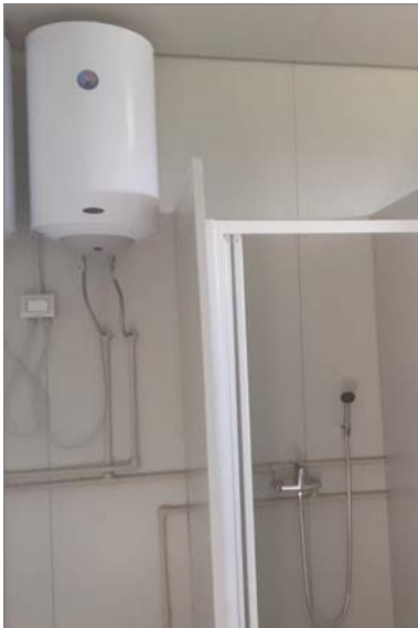
Foto punto di visuale 4 (fabbricato A)
