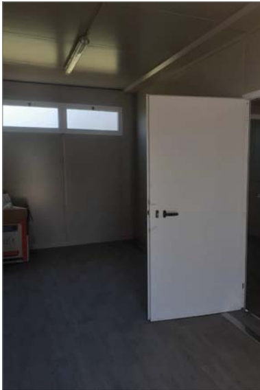
Foto punto di visuale 7 (fabbricato B)
