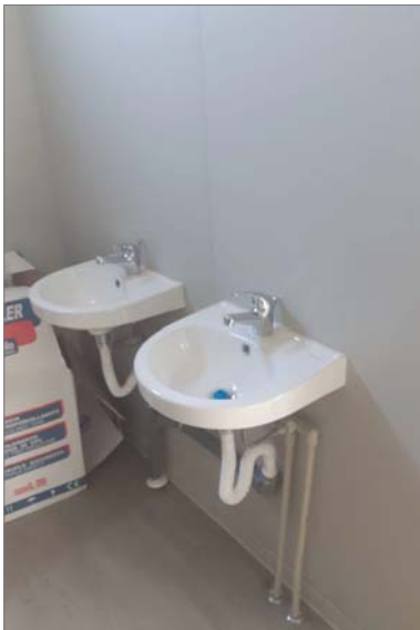
Foto punto di visuale 1 (fabbricato A)
